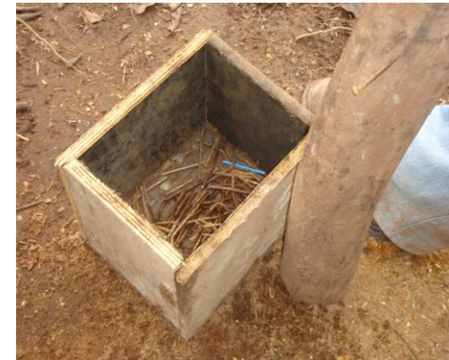
Instalación de una caja para almacenar clavos.
