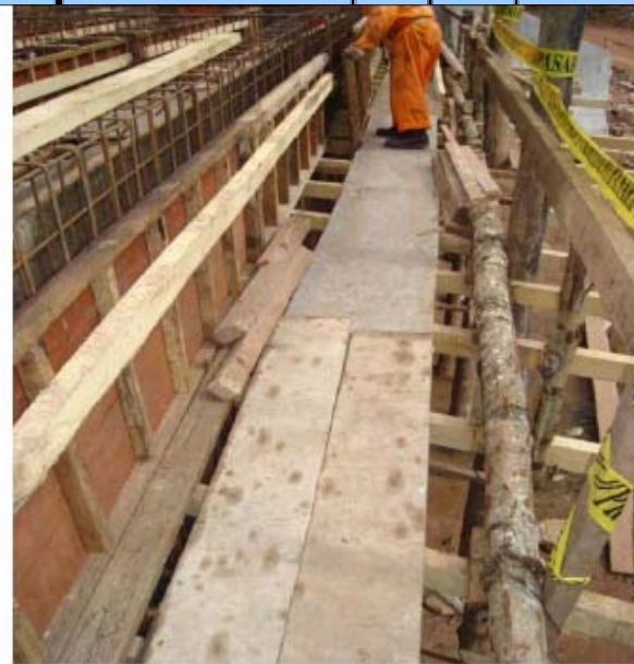
Instalación de tablonés en plataforma y espacios.
